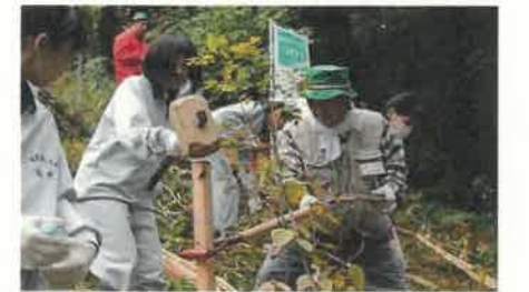
【斜面での支えの打ち込み】
