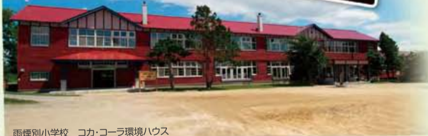
雨煙別小学校 コカ・コーラ環境ハウス
